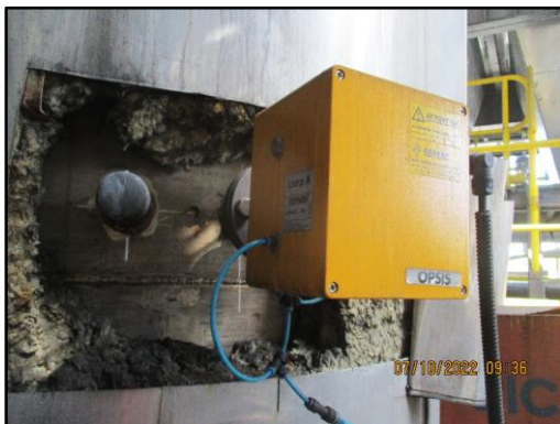
ภาพที่ 2.7 เครื่องตรวจวัดคุณภาพอากาศแบบต่อเนื่อง (CEMs) และระบบ Gas Analyzer ที่ปล่องหม้อไอน้ำ
