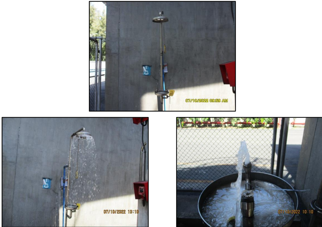
ภาพที่ 2.39 การติดตั้งฝักบัวฉุกเฉินและอ่างล้างตาฉุกเฉินภายในโครงการ
