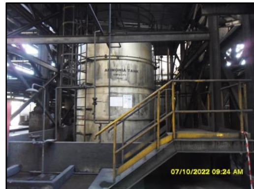
ภาพที่ 2.45 คันคอนกรีตป้องกันการหกรั่วไหลของแอมโมเนีย
