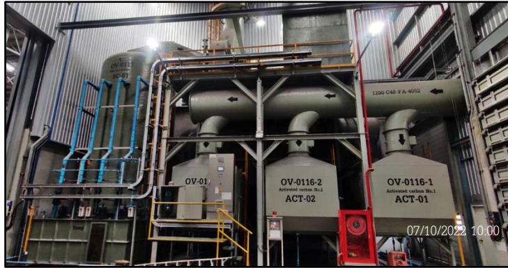
ภาพที่ 2.16 ระบบดูดซับกลิ่นระบบดูดซับกลิ่นด้วย Activated Carbon ร่วมกับระบบบำบัดอากาศเสียแบบเปียก (Wet Scrubber)
