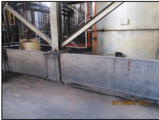
ภาพที่ 2.45 คันคอนกรีตป้องกันการหกรั่วไหลของแอมโมเนีย
