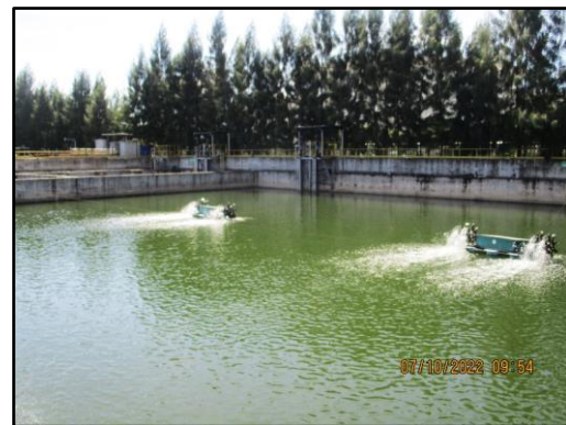
ภาพที่ 2.17 บ่อรับน้ำฝน ขนาด 3,730 ลบ.ม.
