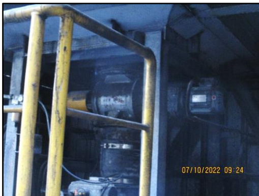
ระบบฉีดถ่านกัมมันต์ (Activated Carbon)
