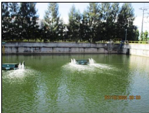
ภาพที่ 2.17 บ่อรับน้ำฝน ขนาด 3,730 ลบ.ม.
