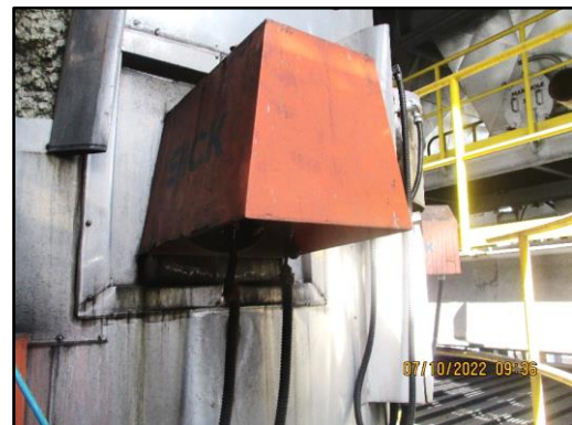
ภาพที่ 2.7 เครื่องตรวจวัดคุณภาพอากาศแบบต่อเนื่อง (CEMs) และระบบ Gas Analyzer ที่ปล่องหม้อไอน้ำ
