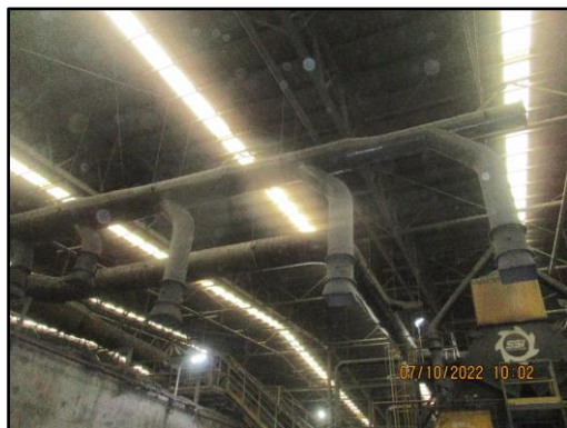
ภาพที่ 2.15 ท่อรวบรวมอากาศอาคารเก็บวัตถุดิบ (กากอุตสาหกรรม)
