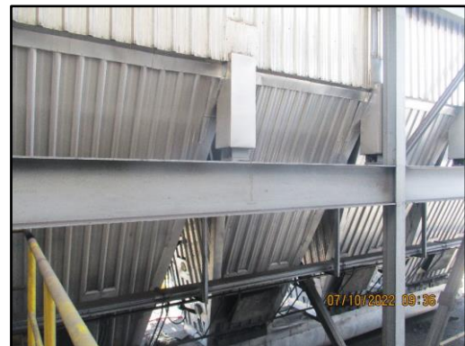
ระบบดักฝุ่นแบบถุงกรอง (Bag Filter)
