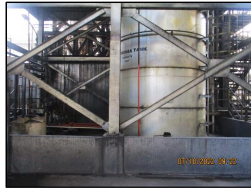
ภาพที่ 2.45 คันคอนกรีตป้องกันการหกรั่วไหลของแอมโมเนีย
