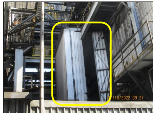
ภาพที่ 2.4 ระบบฉีดถ่านกัมมันต์ (Activated Carbon)
