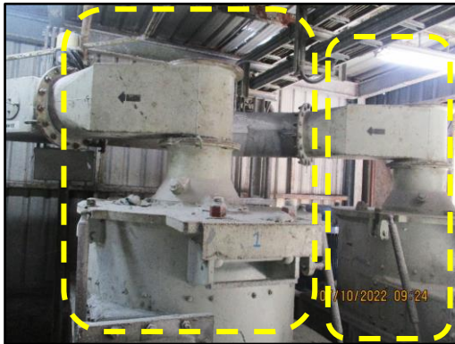
ระบบฉีดโซเดียมไบคาร์บอเนต ( \text{NaHCO}_3 )
