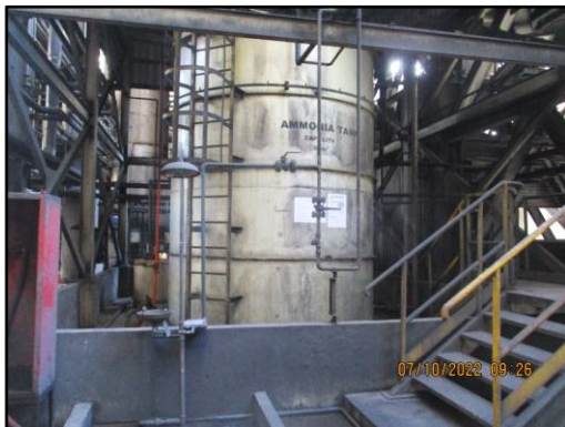
ภาพที่ 2.45 คันคอนกรีตป้องกันการหกรั่วไหลของแอมโมเนีย
