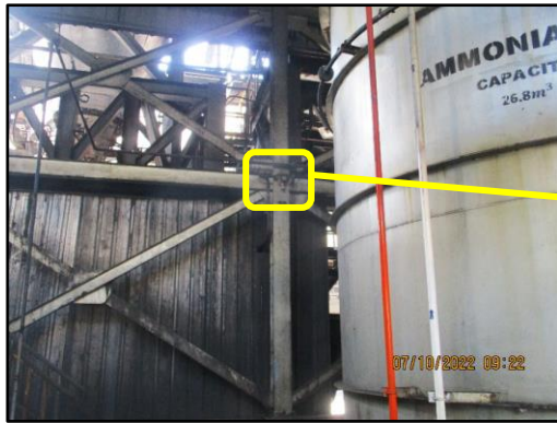
ภาพที่ 2.47 การติดตั้ง Gas detector บริเวณพื้นที่จัดเก็บแอมโมเนีย
