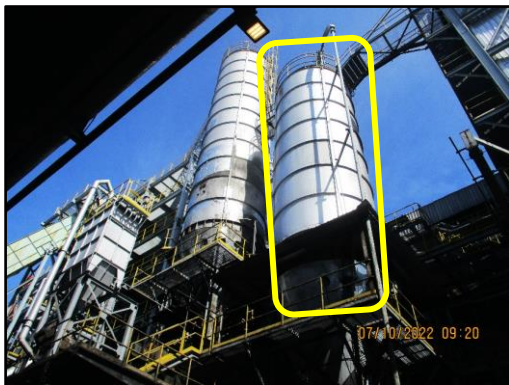
ภาพที่ 2.3 ระบบฉีดโซเดียมไบคาร์บอเนต ( \text{NaHCO}_3 )
