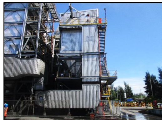
ภาพที่ 2.6 ระบบดักฝุ่นแบบถุงกรอง (Bag Filter)
